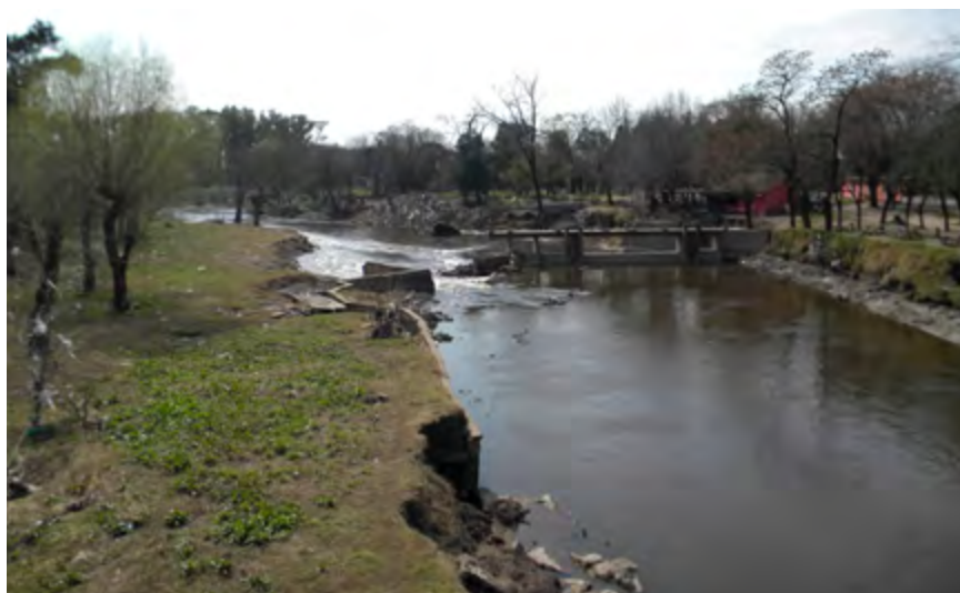
Efectos destructivos de la inundación del río Luján de agosto del 2015
