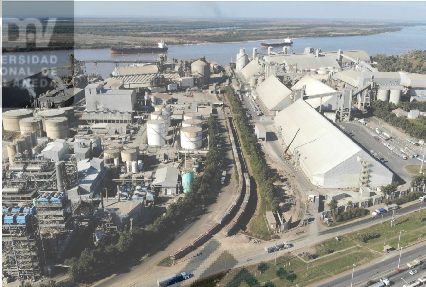
Imagen 5: Instalaciones de la empresa Vicentín. Fuente: https://www.parlamentario.com
