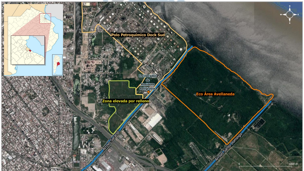
Figura 6. Vista panorámica del área costera de Avellaneda donde se realizará el estudio
