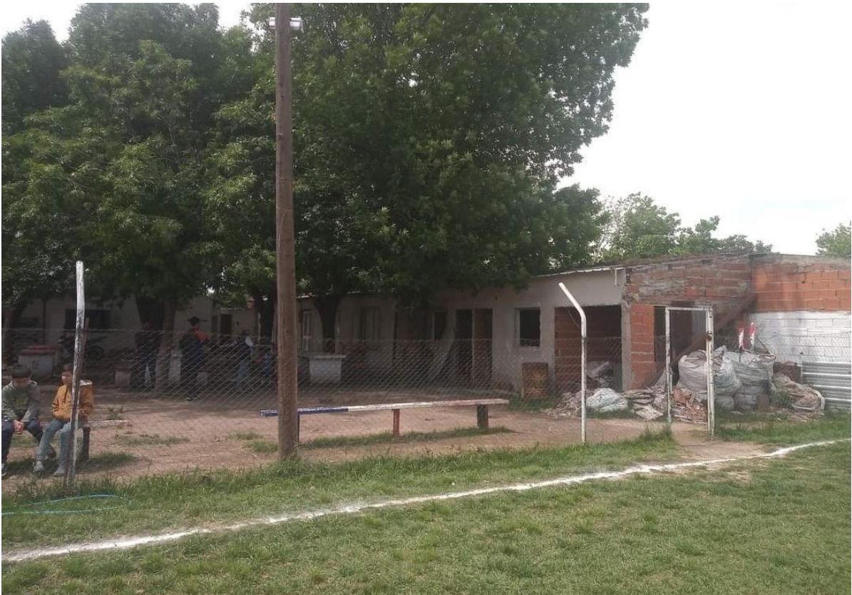
Ilustración n.º8: vestuario en proceso de construcción.
