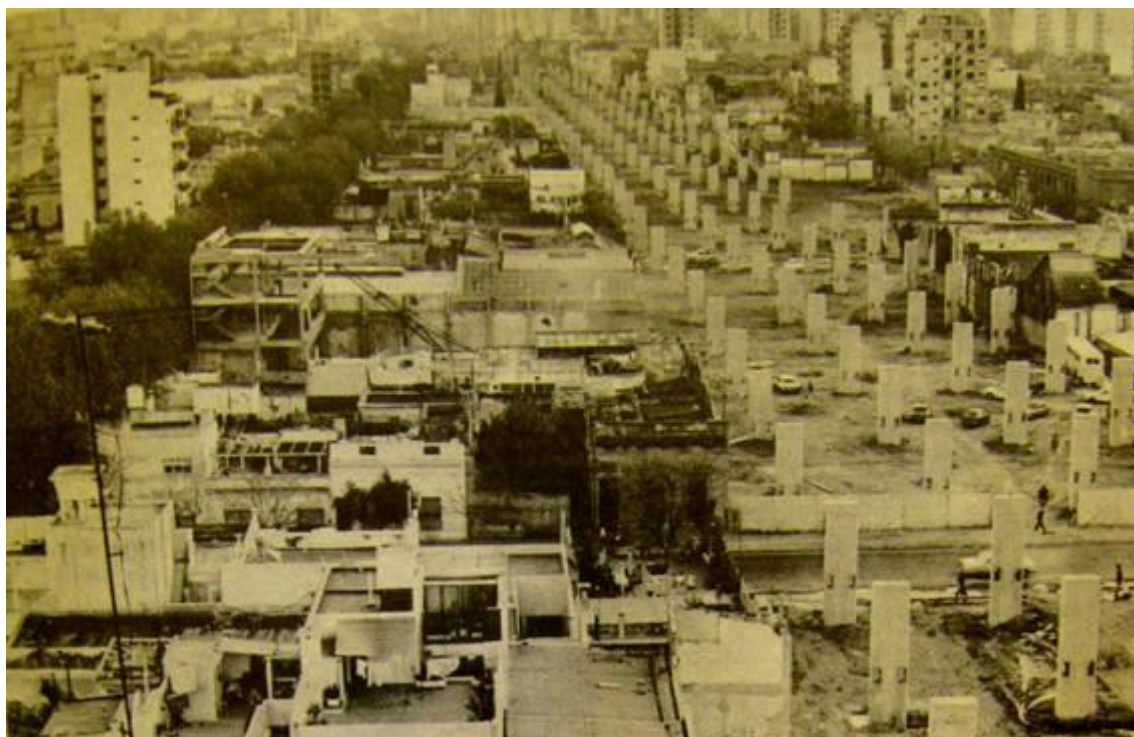
Demoliciones para la construcción de autopistas.
