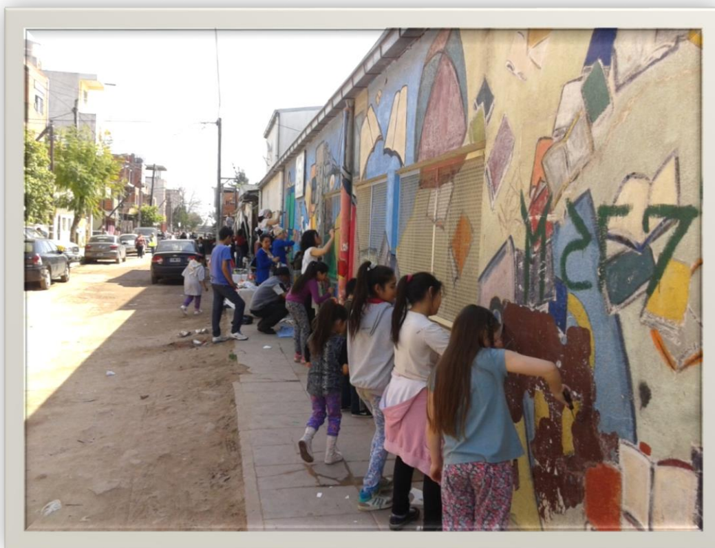
Restauración de la fachada del Centro Educativo Comunitario Ramón Carrillo. Foto: Sebastián Haffner (2017)
